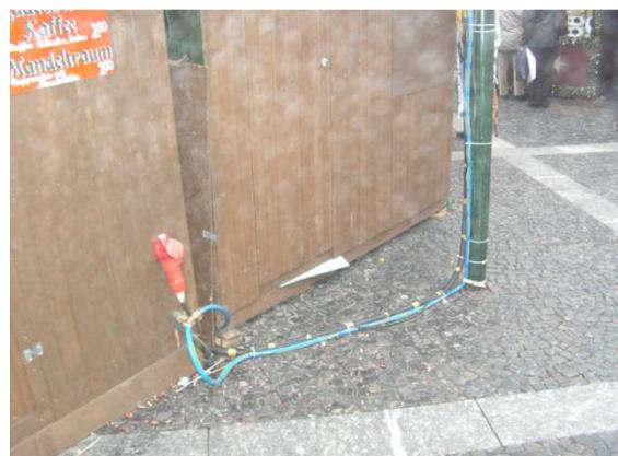
Abb.16: Unverdecktes Stromkabel
